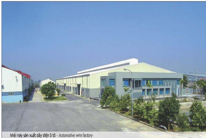
Nhà máy sản xuất dây điện ô tô - Automotive wire factory
