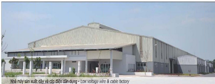
Nhà máy sản xuất dây và cáp điện dân dụng - Low voltage wire & cable factory
